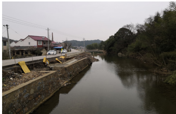
图 1 白马河典型岸坡病害现场照片
