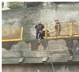
图 9 现场安装靶标
