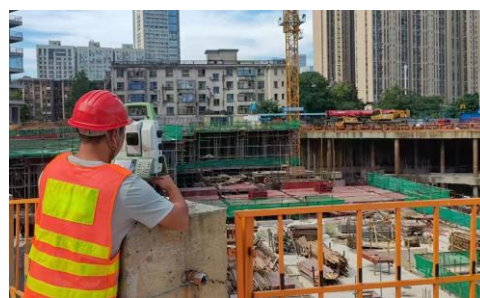
图 3 内支撑拆除期间的实时监测现场照片
