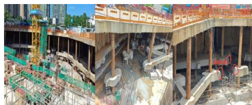
图 2 基坑内支撑拆除现场
