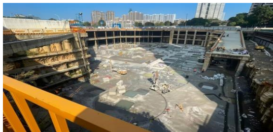
图 1 基坑支护全貌图
